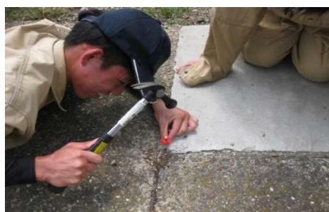
測点の設置作業
