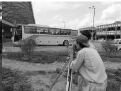
伊丹空港施工の為の測量
